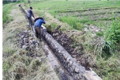
Perbaikan dan pemeliharaan saluran air kebun
