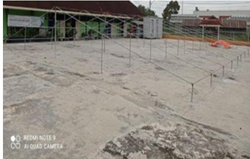
Perbaikan sarana lantai jamur
