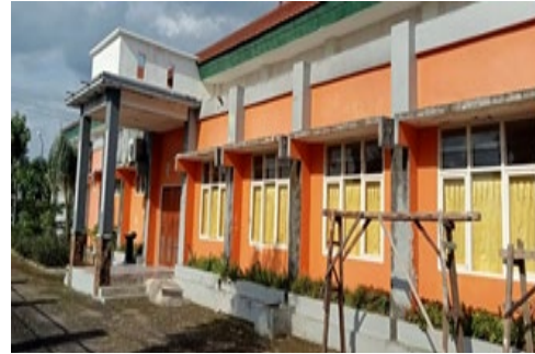
Pengecatan gedung UPBS
